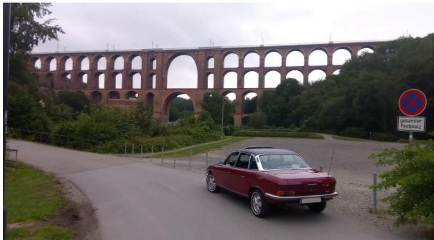
Göltzschtalbrücke im Vogtland ist die größte Ziegelbrücke der Welt, 573m lang, 78m hoch und es wurden 26 Millionen Ziegel verbaut. Das imposante, fast 170 Jahre alte Viadukt ist noch voll funktionstüchtig und kann von der Bahn mit bis zu 160km/h überfahren werden.[1]
